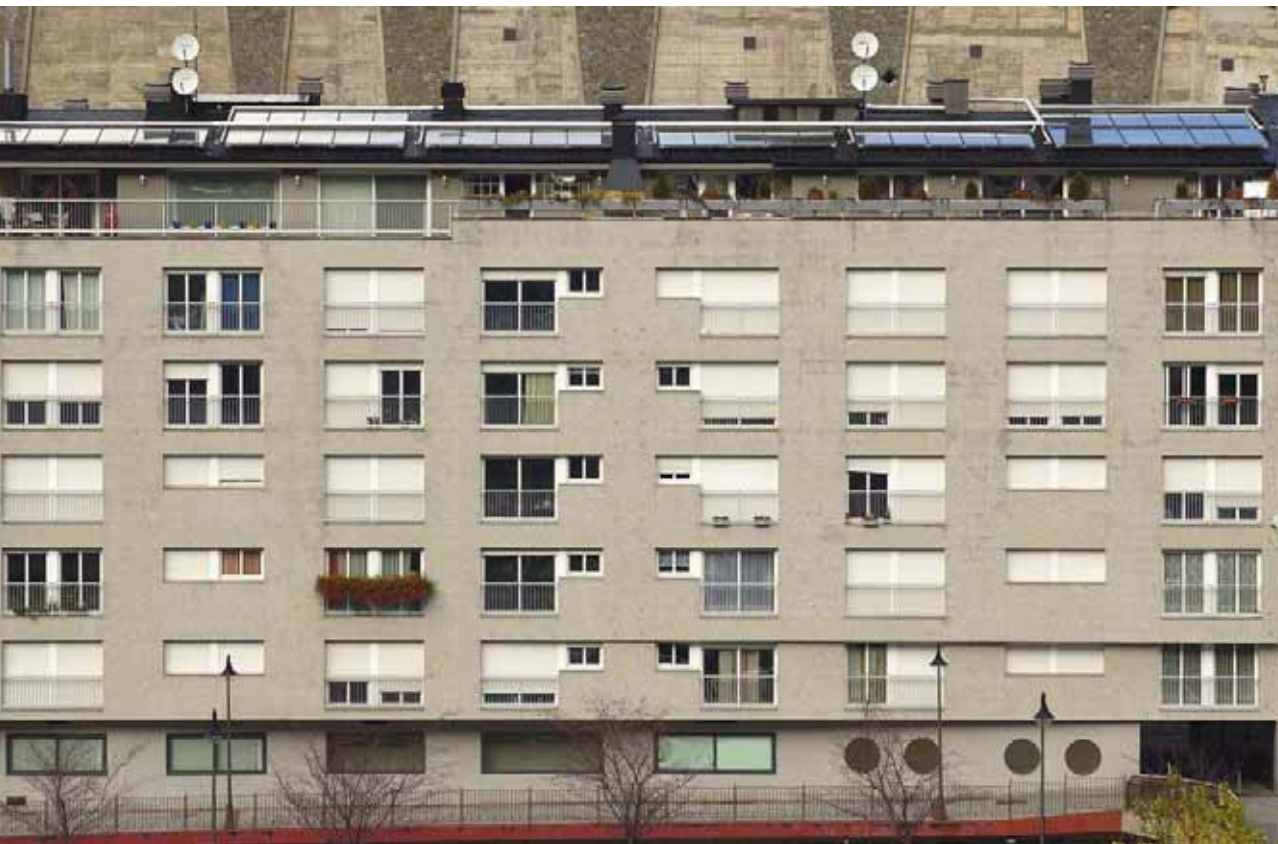
Edifici amb energia solar tèrmica
