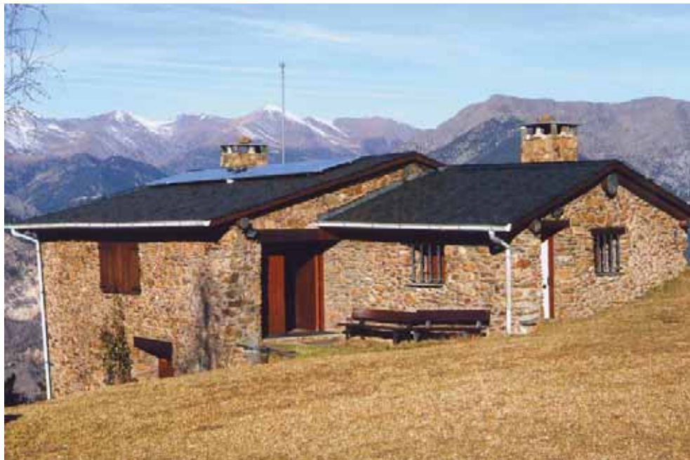
Borda amb energia solar fotovoltaica
